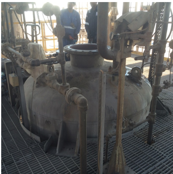
Vedlikehold av reactor top
