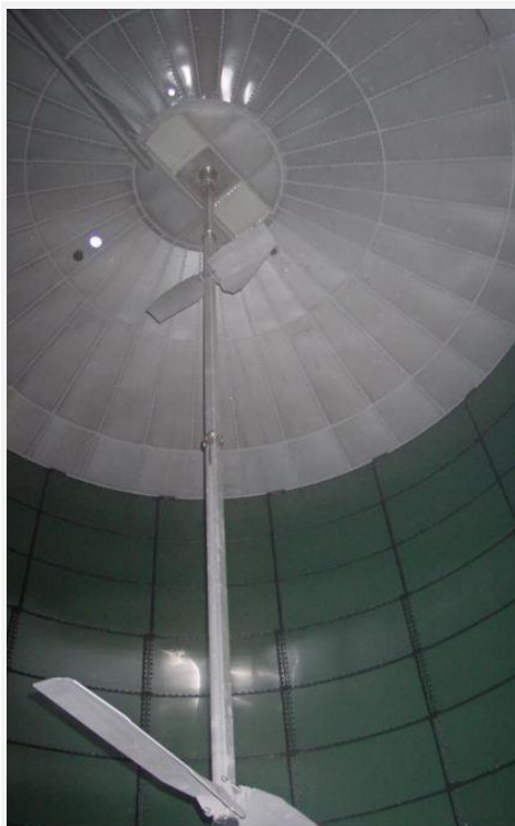
Propelleromrører i råtnetank
